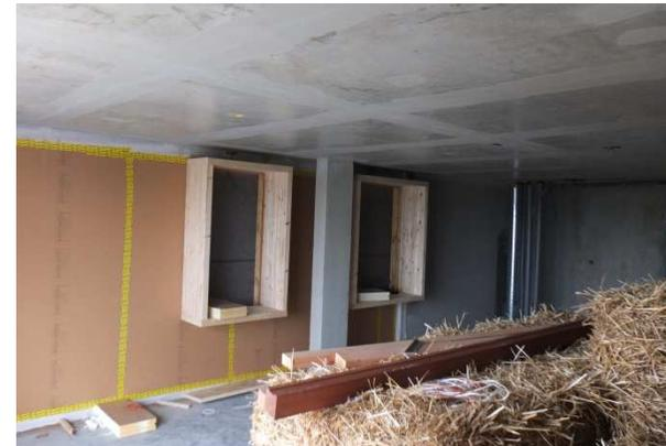
*Murs, poteaux et dalles béton armé
